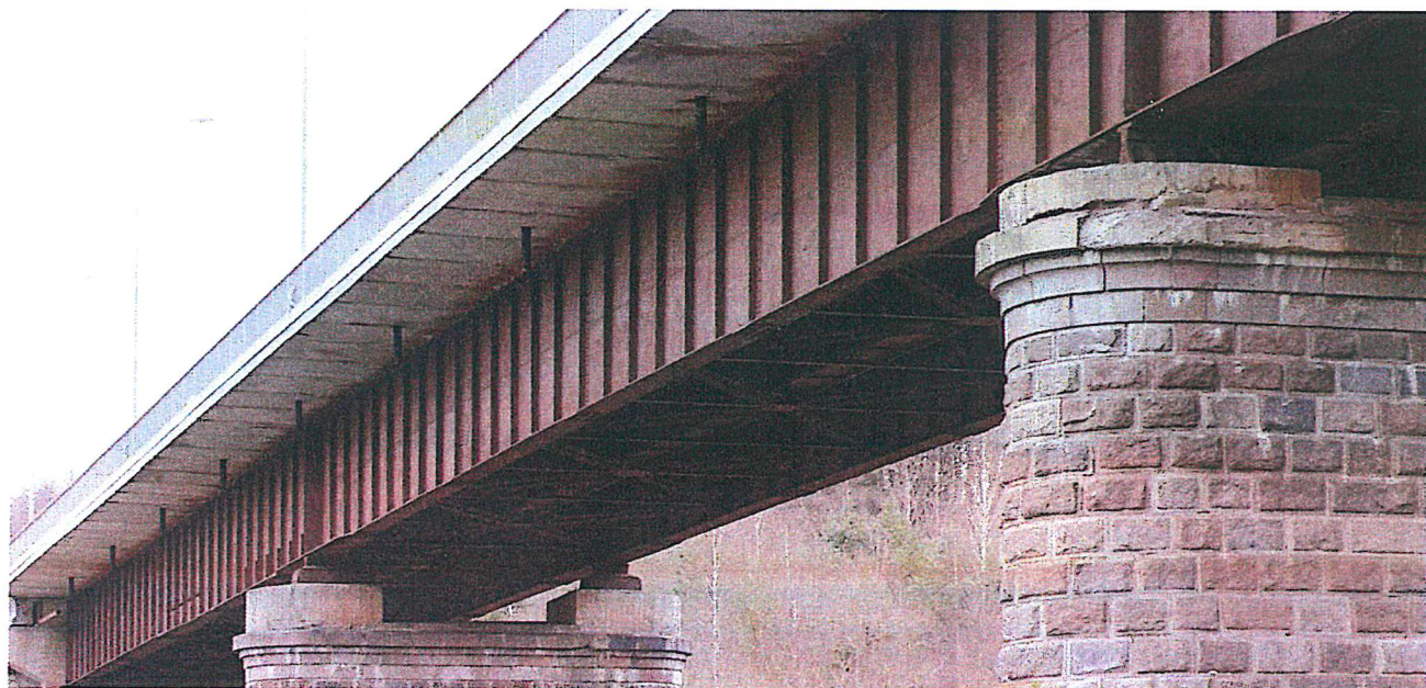
2.15 pav. Plienbetoninėje perdangoje vandens nuleidimo šulinėliai per trumpi, vaizdas iš žemupio pusės
