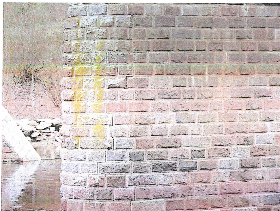
2.14 pav. Ketvirtos atramos vaizdas nuo žemupio pusės. Atramos paviršiuje vandens bėgimo žymės, tarp akmenų plyšys
