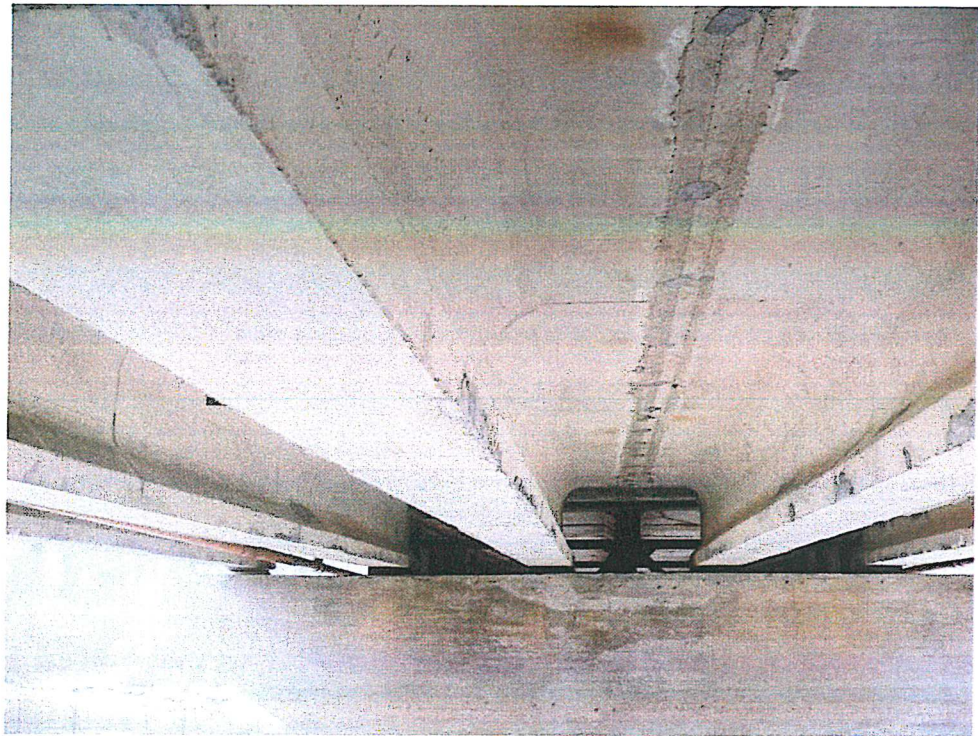
2.8 pav. Gelžbetoninių sijų vaizdas iš apačios penktame tarpatramyje
