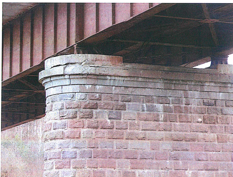
2.13 pav. Ketvirtos atramos vaizdas nuo žemupio pusės. Tauro galvenos betonas aptrupėjęs
