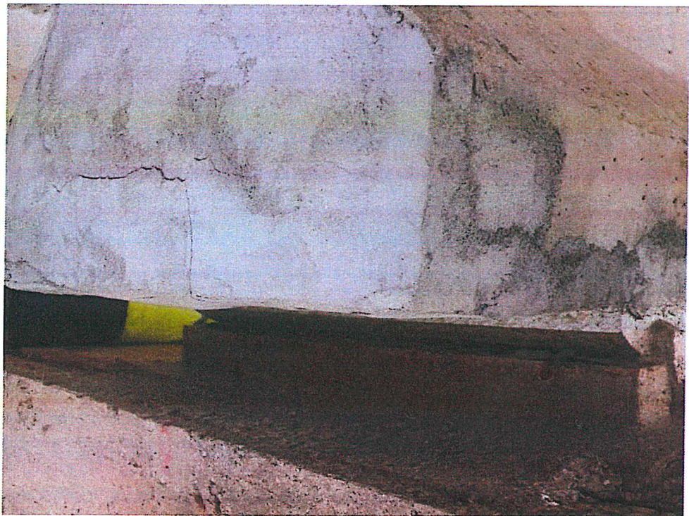
2.7 pav. Gelžbetoninės sijos galo ir atraminės dalies vaizdas virš penktos atramos, atraminė dalis turi korozijos židinių, sijos galas užtinkuotas ir sutrūkęs
