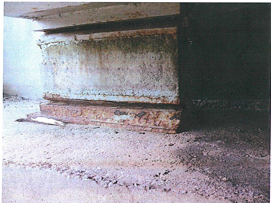
2.9 pav. Šeštos atramos, šeštos sijos atraminė dalis, metalinių dalių paviršiuje korozijos židiniai
