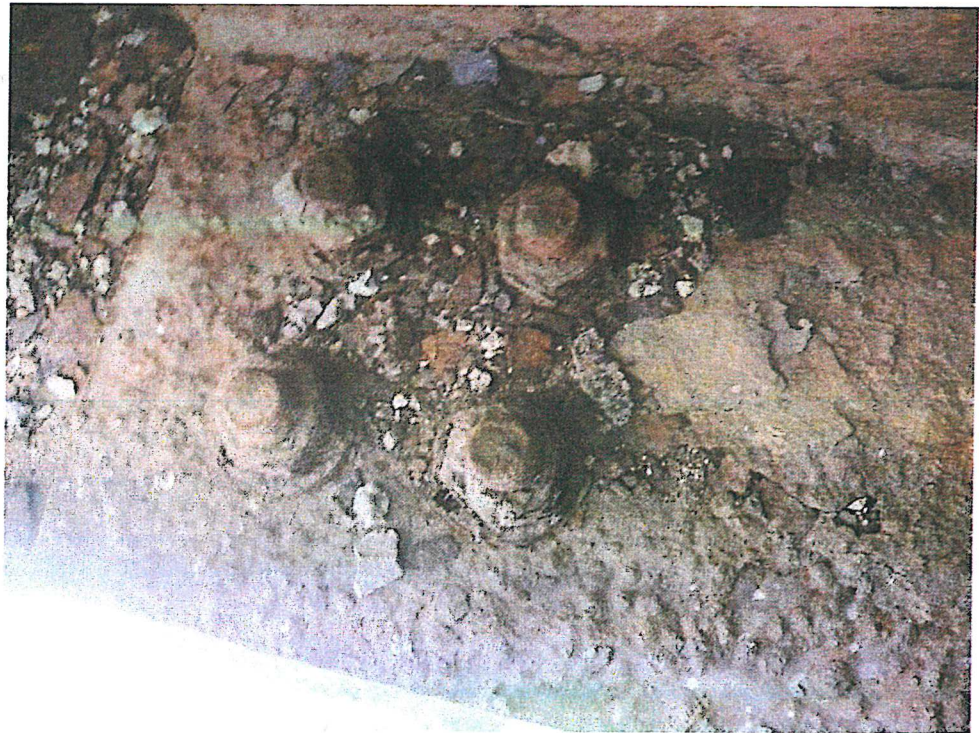
2.6 pav. Skersinės ir išilginės sijų sujungimo mazgas virš antros atramos. Skersinė sija ir varžtai stipriai pažeisti korozijos
